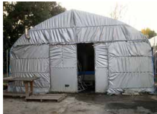
シートハウスプラント
