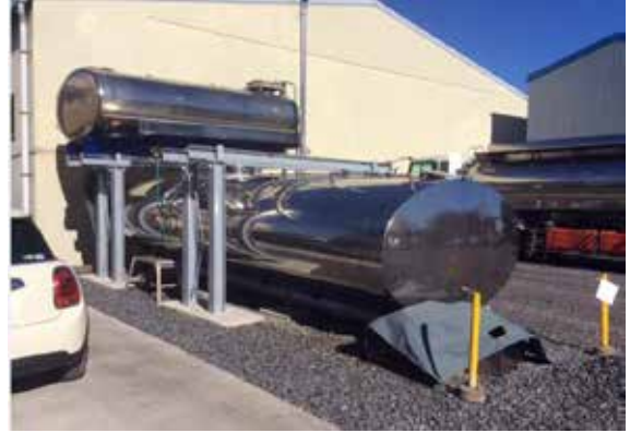
車庫内の補強タンク
