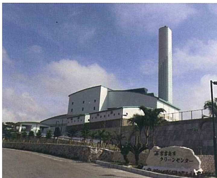
図2-4 宮古島市クリーンセンターの外観
