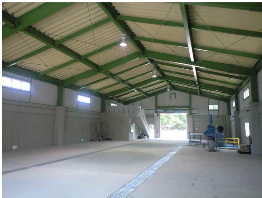
図2-5 伊良部リサイクルセンターの内観
