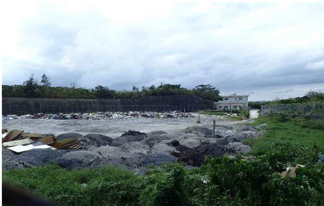
図2-7 川満一般廃棄物最終処分場
