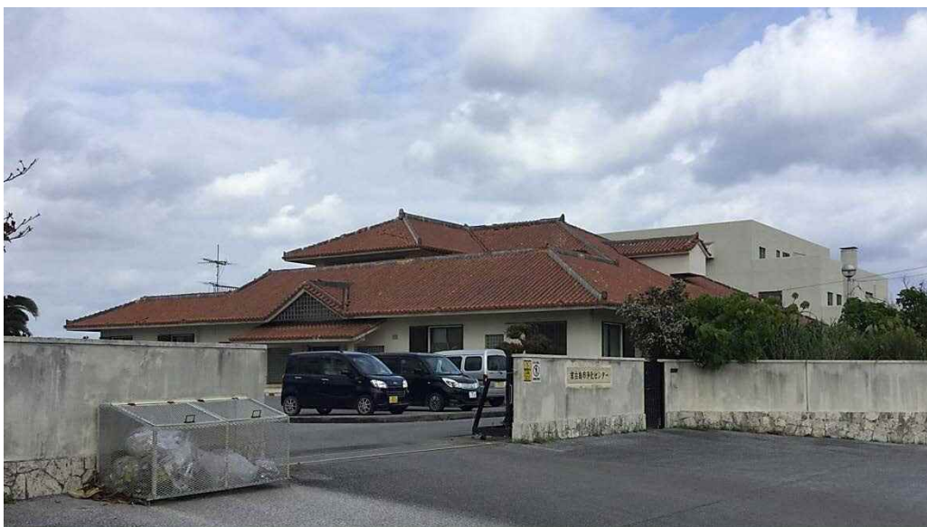
図3-3 宮古島市公共下水道施設の外観
