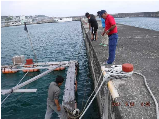
中枠の引き上げ
