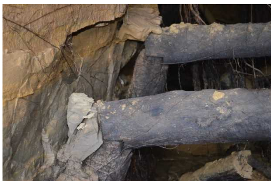
写真2 柱と梁の接ぎ木の状況
