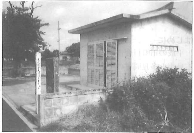
写真 ① 村番所の跡地と祭祀小屋（2010年3月撮影）
