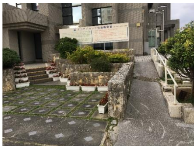
▲正面入口のスロープ（平良庁舎）
