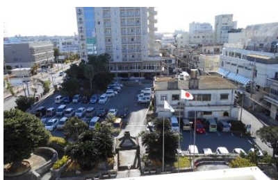
▲平良庁舎の駐車スペース
