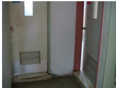
▲トイレ入口の段差。つまずきの原因になることも懸念される。（平良庁舎）
